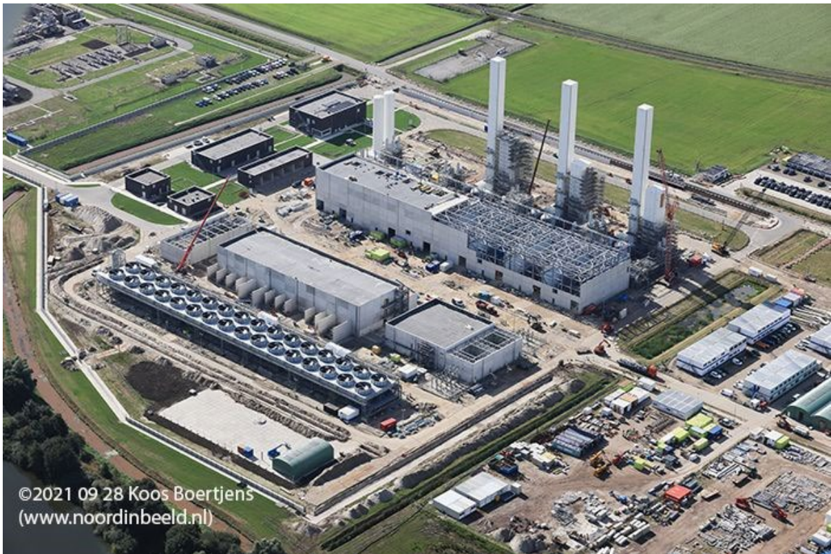
Photo de la construction de l'usine de production d'azote Gasunie à Zuidbroek.
